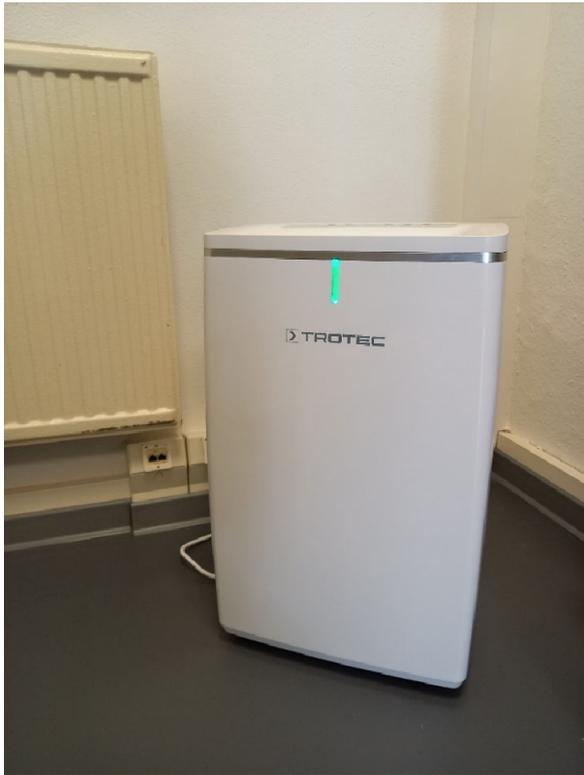
Abb. 34: Entfeuchtungsgerät zur Regulierung der relativen Luftfeuchtigkeit
